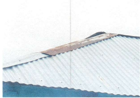
Foto 2: Sustitución de capote de lamina por lamina troquelada
