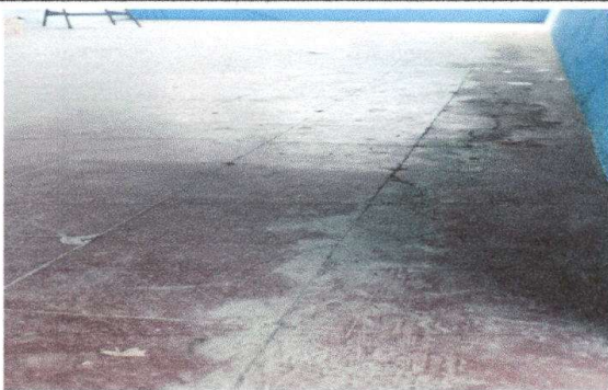
Foto 3: Sustitución de piso ceramico
